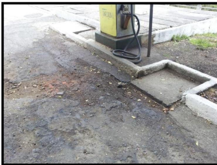
**Figura No. 50:** Suelo con manchas de combustible en la gasolinera de la AGE
