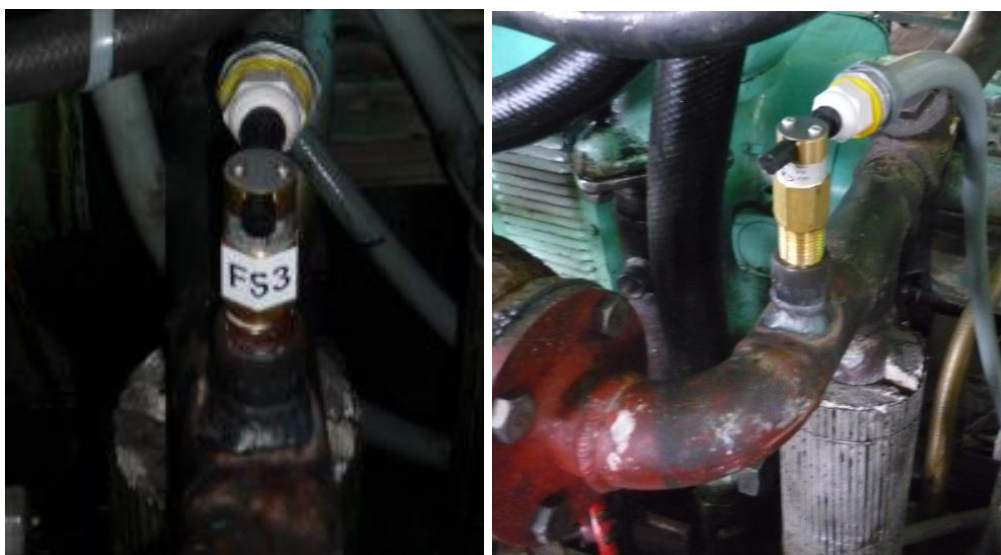
Fotografía. 5. 2. Instalación de switch de Flujo en la tubería de bypass.
