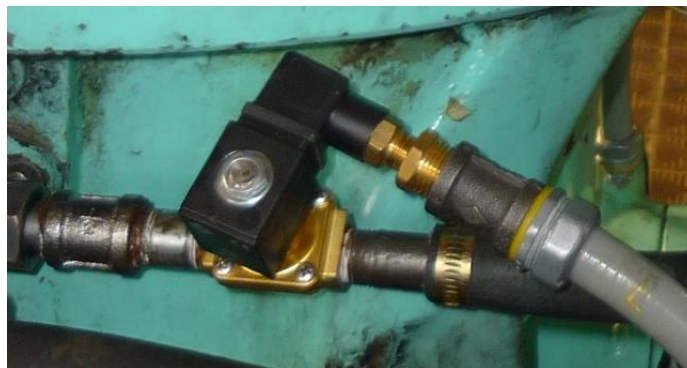
Fotografía. 5. 7.Instalación de la Electroválvula para agua de maniobra.
