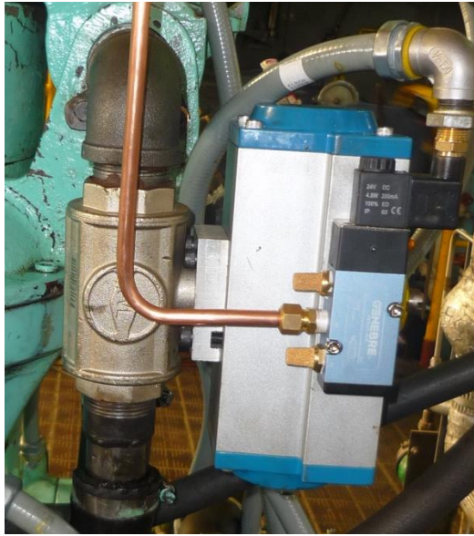
Fotografía. 5. 10. Instalación de la Válvula de 3 vías.
