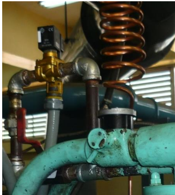
Fotografía. 5. 8. Instalación de la Electroválvula para Llenado de bola.
