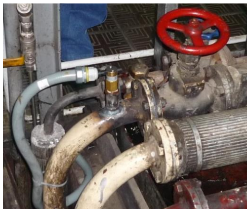
Fotografía. 5. 4. Instalación de switch de Flujo en la salida de aceite.
