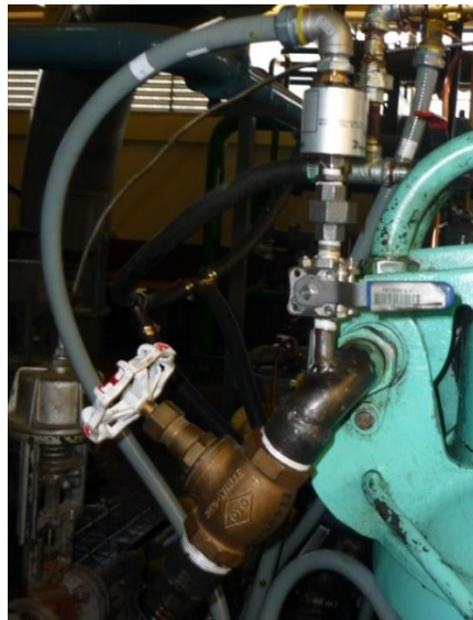
Fotografía. 5. 5. Instalación de Transmisor de presión y válvula de globo.
