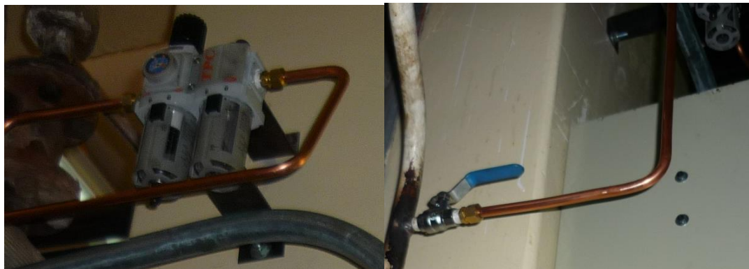
Figura. 5. 11. Instalación de la Unidad de Mantenimiento y válvula de bola.
