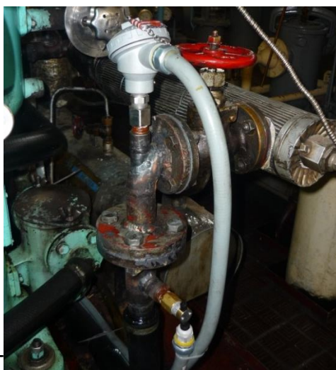
Fotografía. 5. 1. Instalación de switch de Flujo y Transmisor de Temperatura.
