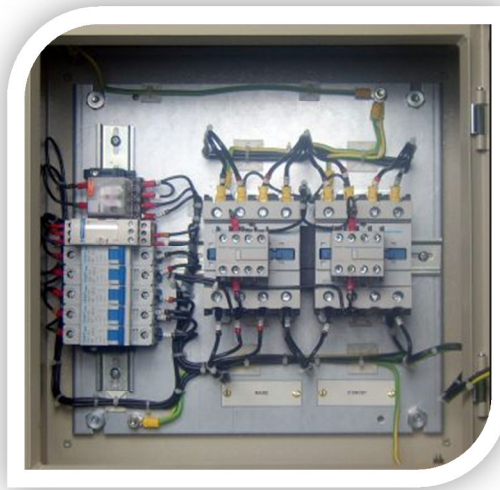
Figura 8 Contactores
