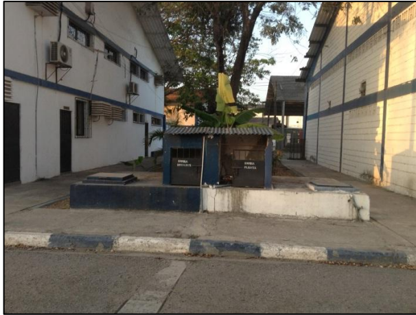
Figura2 Instalaciones de CODESC
