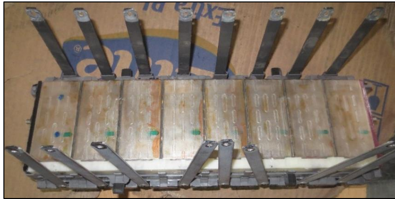
Figura 4. 35 Ubicación de los módulos y separadores.
