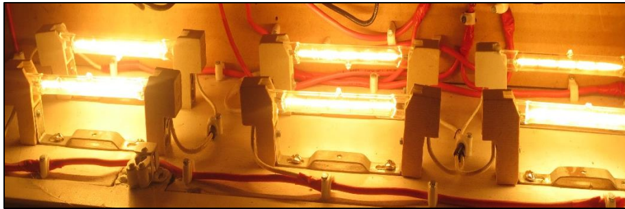
Figura 4. 26 Focos halógenos de descarga activados.
