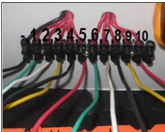
Figura 3. 28 Orden de colores de los conductores.
