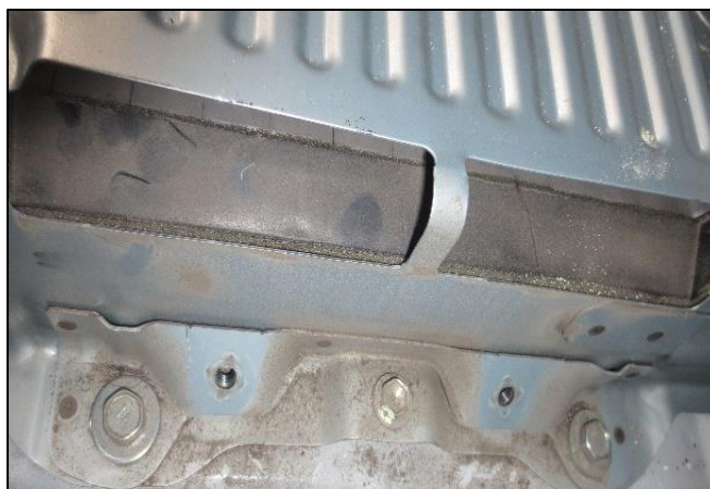
Figura 4. 18 Ventilación delanteras de los bloques.
