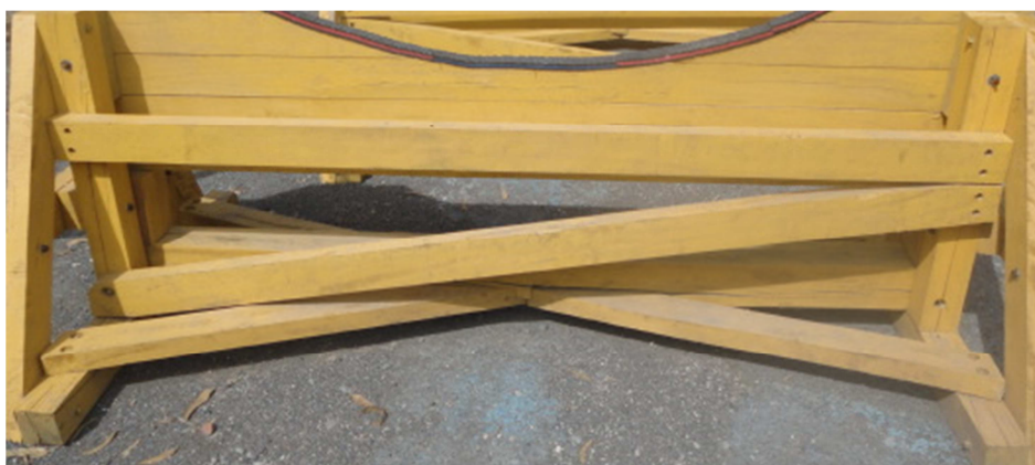
Fig. 3. 14 Colocación de los refuerzos delanteros
