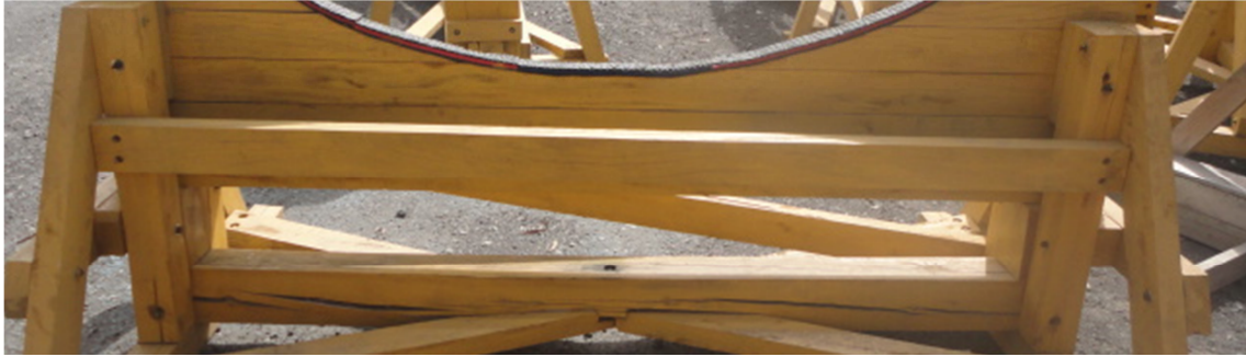
Fig. 3. 15 Colocación del refuerzo trasero
