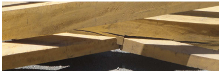
Fig. 3.11 Colocación de los travesaños en la viga central.
