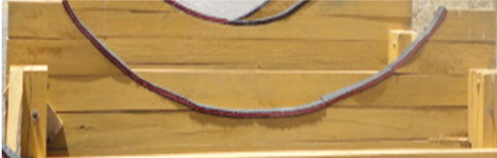
Fig. 3. 16 Ensamblaje del tablero
