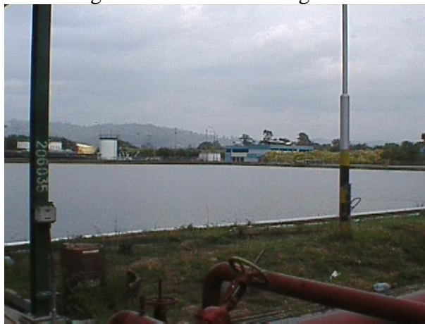
Fotografía 5.7 Piscinas de agua cruda
