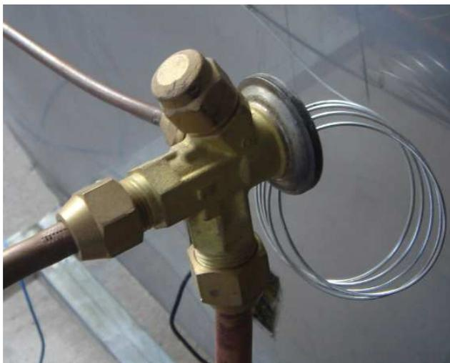
**Figura 5-12 Ensamble de la válvula de expansión.**
