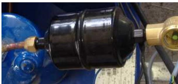
**Figura 5-15** Ensamble del filtro.
