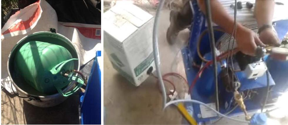
**Figura 5-23 Carga del refrigerante en la unidad de refrigeración.**
