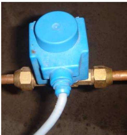
**Figura 5-13 Ensamble de la válvula solenoide.**
