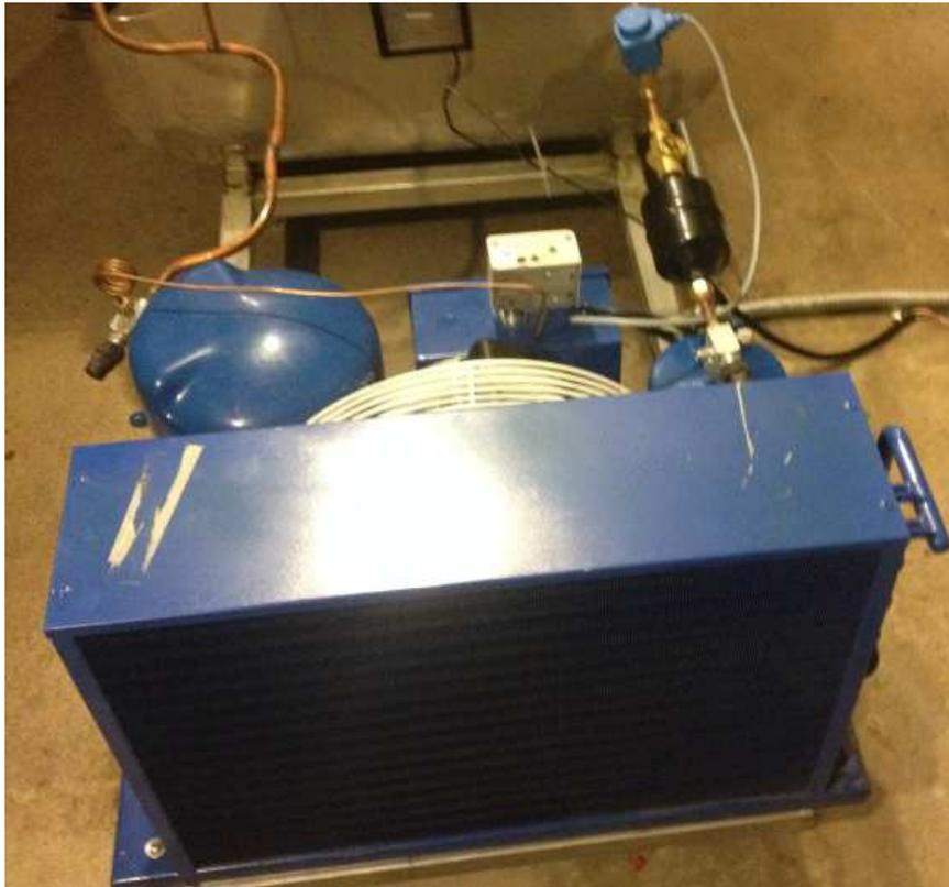
**Figura 5-11 Ensamble de la unidad condensadora Danfoss.**
