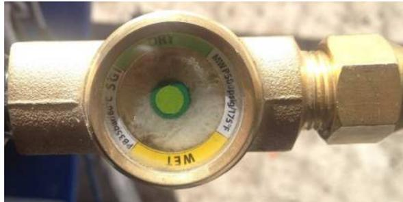
**Figura 5-14** Ensamble del visor de humedad.
