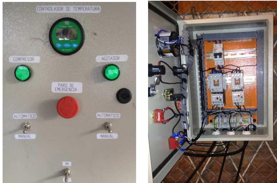
**Figura 5-17 Conexión eléctrica en el gabinete principal.**
