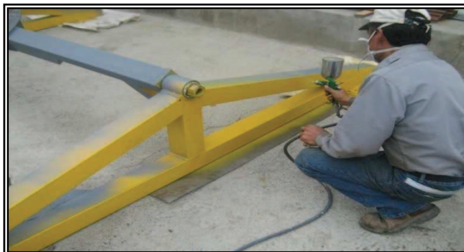
Figura 3.16 Proceso de pintura del soporte de la estructura simuladora.
