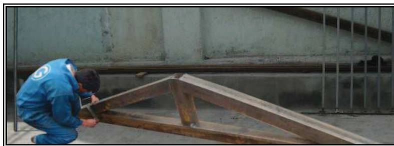
Figura 3.12 Alineación de los miembros laterales.
