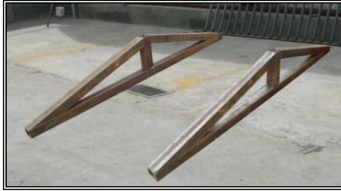
Figura 3.13 Bases laterales del soporte construidos.
