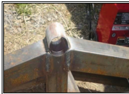
Figura 3.14 Proceso de suelda de las camisas en su columna respectiva.
