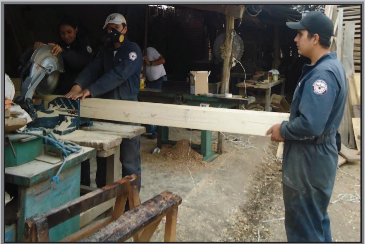
Figura 3.7. Corte de las vigas
