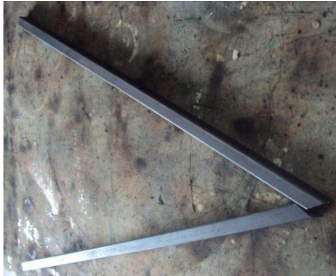
Figura 3.29: Soldando los soportes Fuente: Sr. Valencia Johnatan
