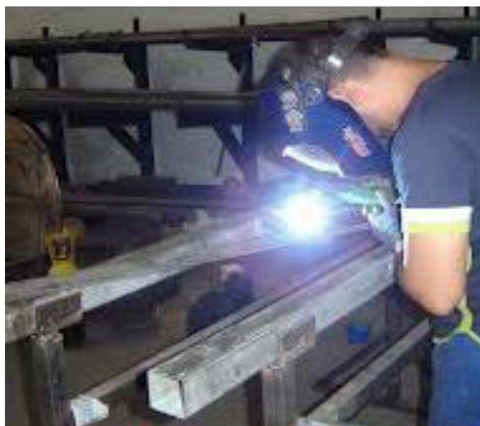
Figura 3 .28: Soldando los tubos de la estructura Fuente: Sr. Valencia Johnatan
