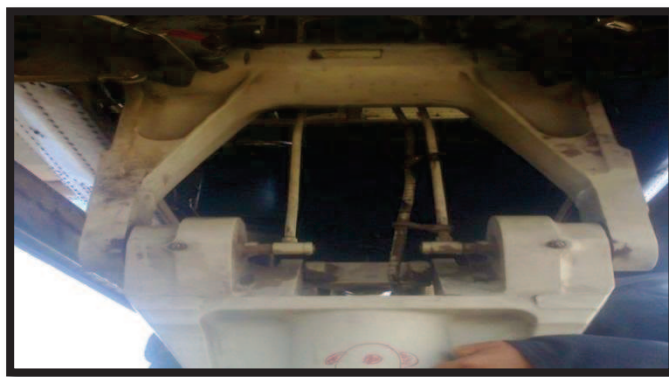
Figura: 3.12. Pasadores puestos en los seguros del montante amortiguador
