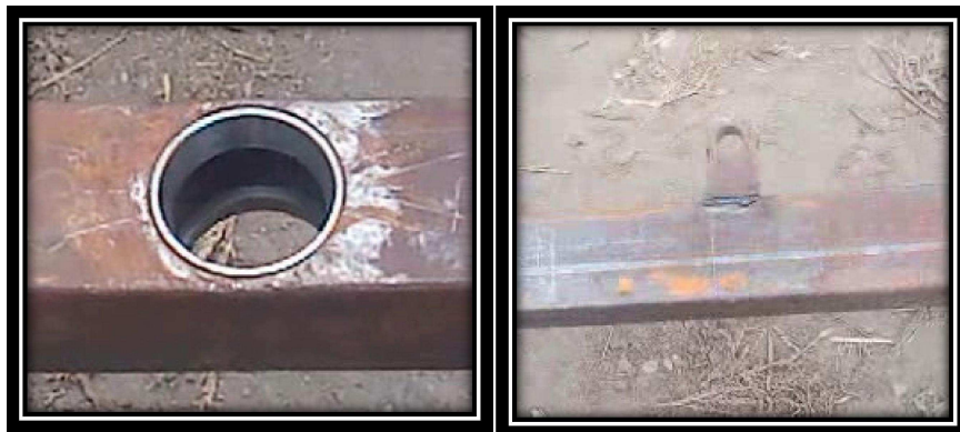
Figura 3.39. & 3.40. Suelda implementada en sujeción de elementos principales
