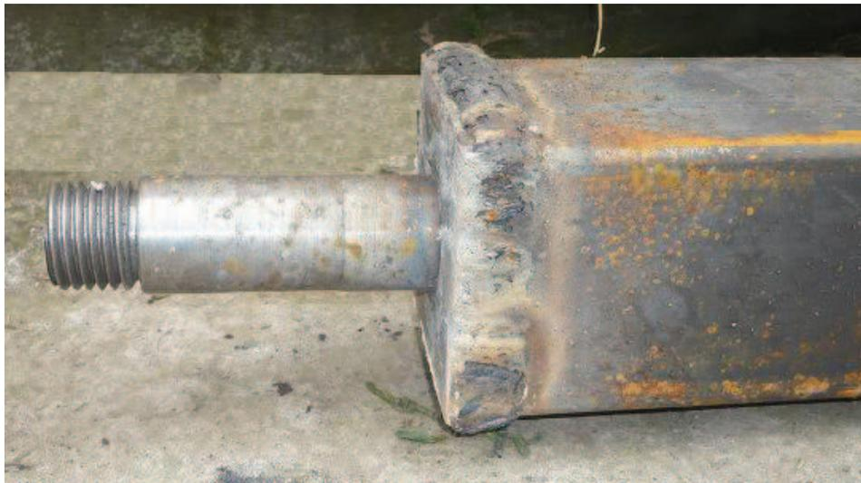
Figura 3.16 Punta de eje soldada al costado del tubo estructural cuadrado
