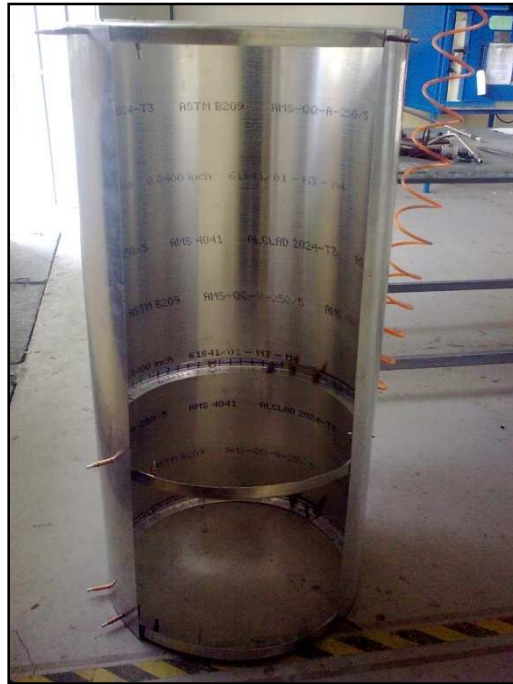
Figura 2.66: Colocación de los circunferenciales internos por medio de clecos.
