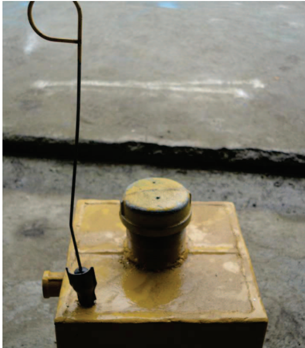
Figura 3.7 Sistema de medición mediante bayoneta.
