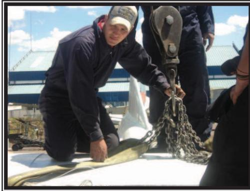
**Figura 3.48.** Colocación de fajas alrededor del ala central (montacargas pequeño).
