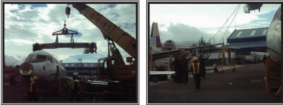
**Figura 3.59.** Soga de control, amarrada a la sección del ala central.
