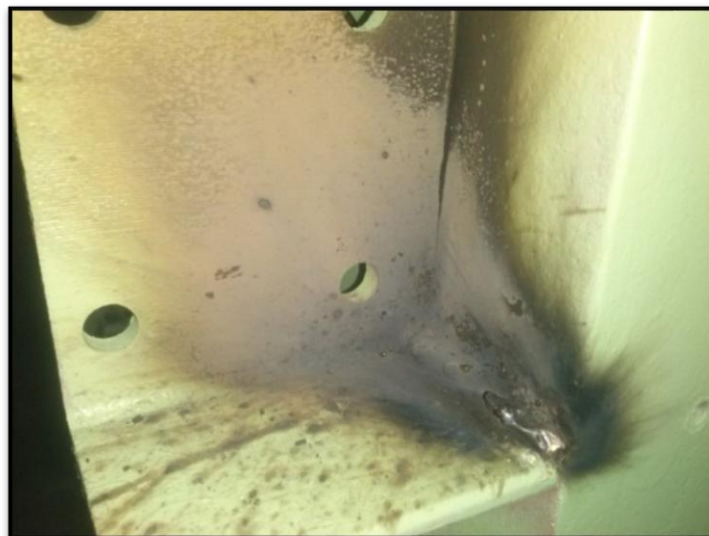
Figura 4.12 Soldadura del soporte para el conjunto reductor.
