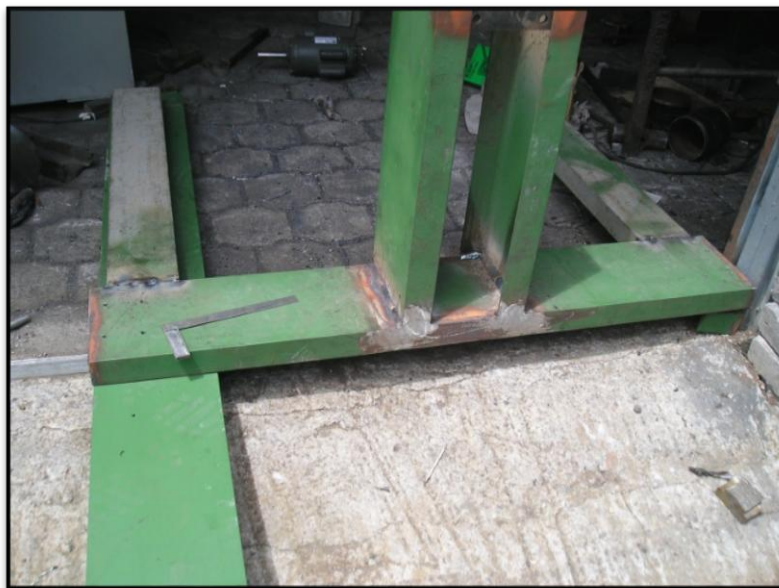
Figura 4.10 Soldadura de la bancada.
