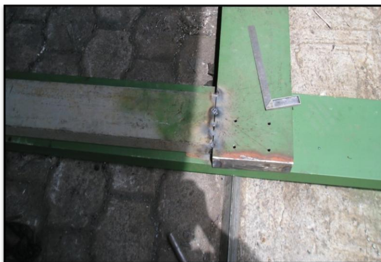
Figura 4.9 Nivelado y soldadura de vigas.
