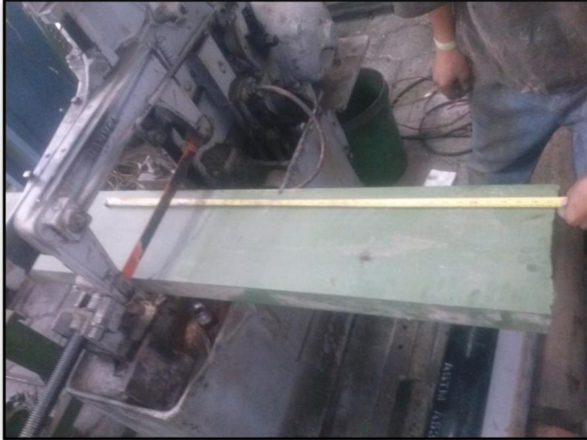
Figura 4.5 Medición y trazado de vigas.
