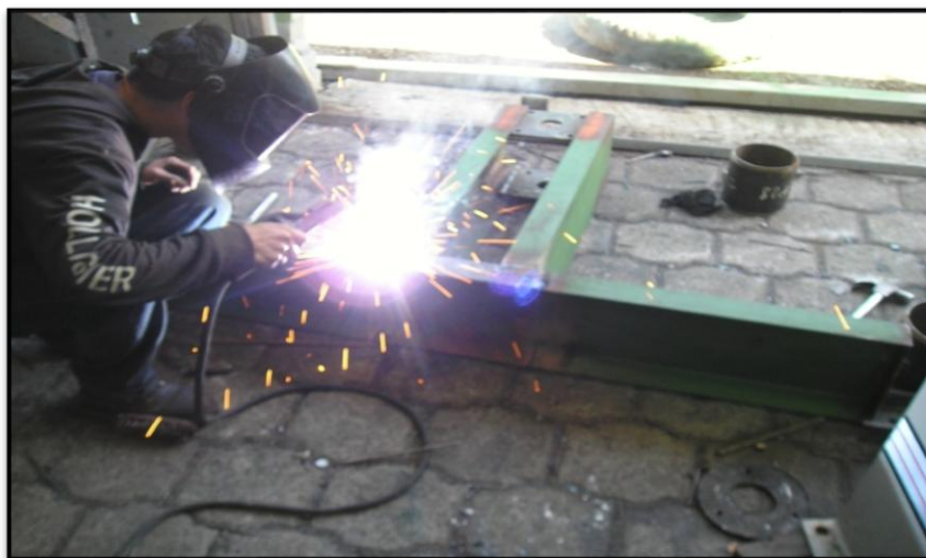
Figura 4.14 Soldadura de bancada en parte externa.
