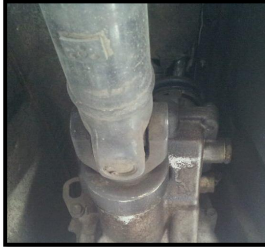
Figura 3. 11 Instalación del eje propulsor.
