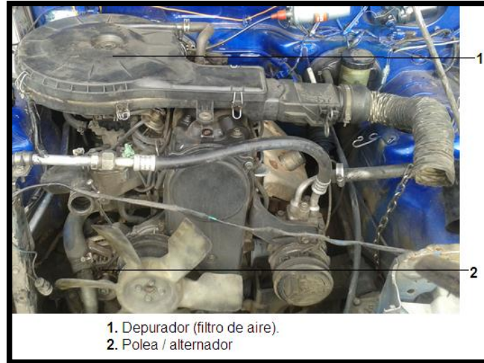
Figura 3. 4 Instalación del depurador (filtro de aceite).
