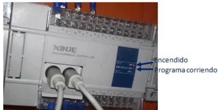
Figura 4.2: Verificación del encendido del PLC.
