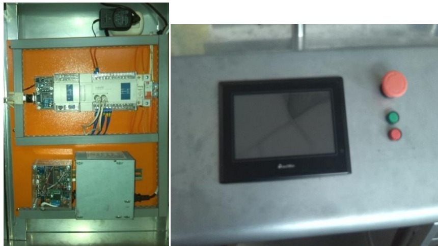
Figura 3.22: Montaje de elementos eléctricos y electrónicos.
