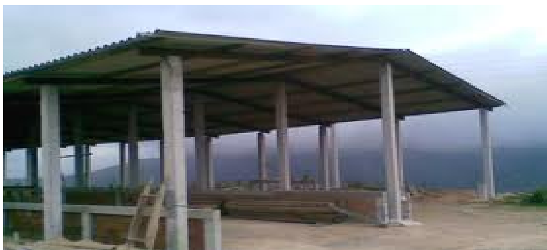
Figura 28 Área de almacenamiento
