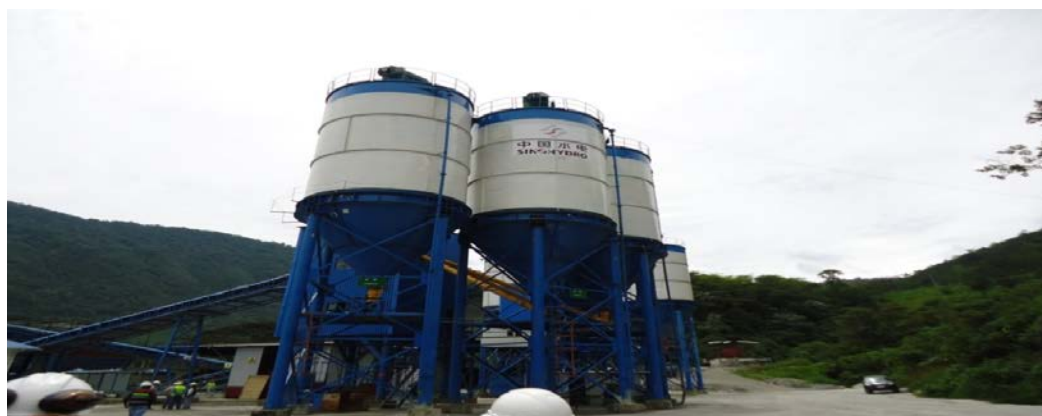
Figura 30 Área de almacenamiento
