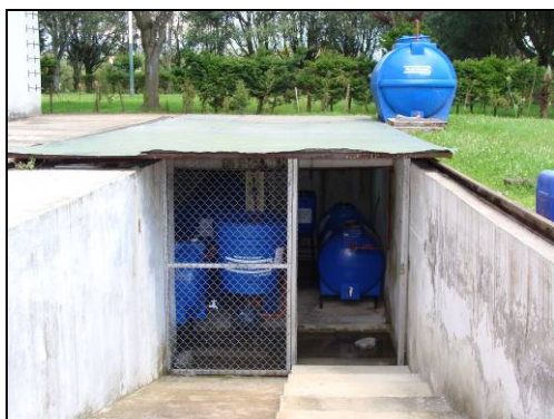
Figura 8.1. Vista frontal de la Planta Piloto.
