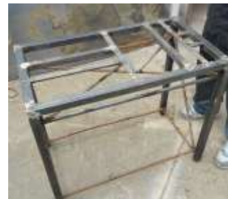
Figura 6: Corte y soldado de la estructura. Fuente: Cabascango, Dávila
