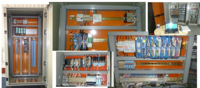
Figura 27: Fabricación de Tableros
