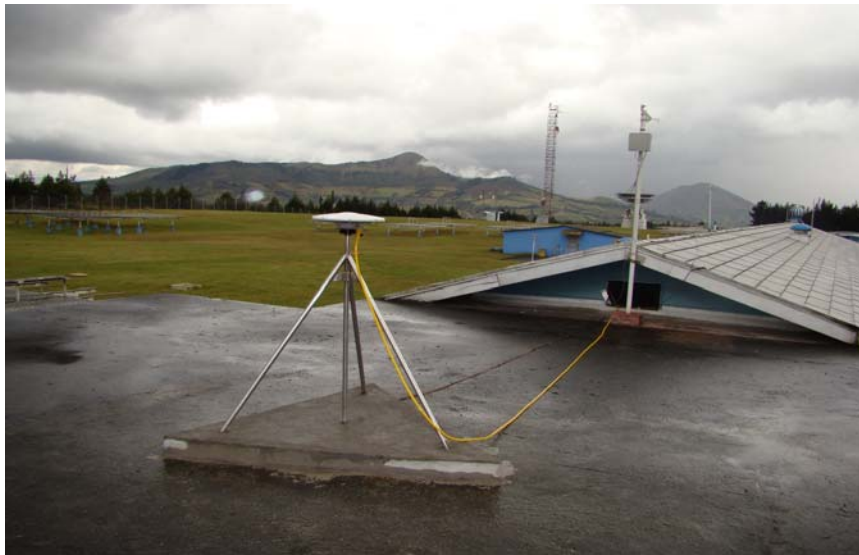
Foto. 5.4 Antena Zephyr Geodetic instalada en trípode de acero inoxidable empotrado en base de cemento
