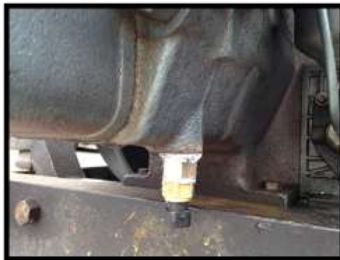
Figura 4.7 Instalación del sensor de temperatura agua motor.
