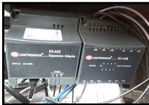
Figura 4.31: Módulo de expansión de I/O analógicas
