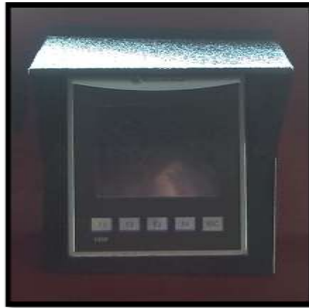
Figura 4.8 Instalación de la pantalla del tablero.
