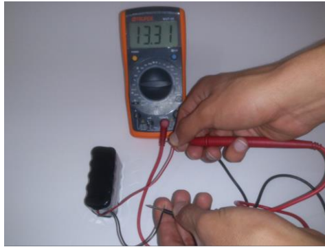
Figura 4.5. Medición de voltaje en la batería.
