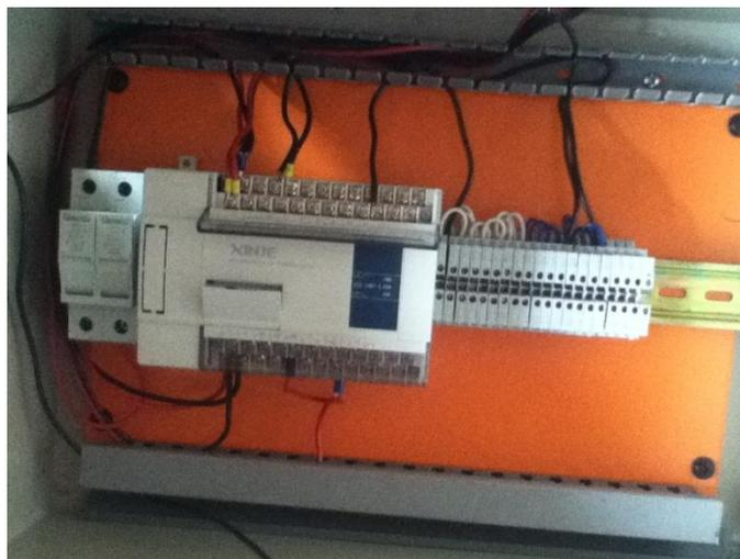
Figura 4.29: Conexiones del PLC
