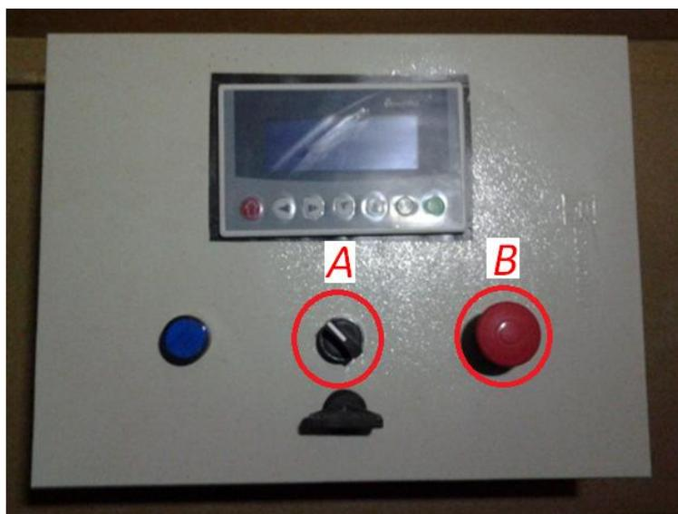
Figura 5.3: Interruptor de encendido y paro de emergencia
