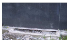
Inspección anillo anular externo al tanque
