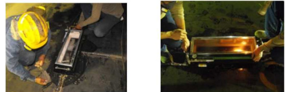
Pruebas con cámara de vacío a todos los cordones de suelda
