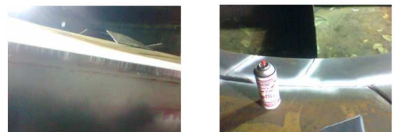
Pruebas con líquidos penetrantes en cordones de suelda del sumidero
