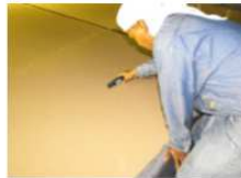
Aplicación del recubrimiento al piso nuevo.
