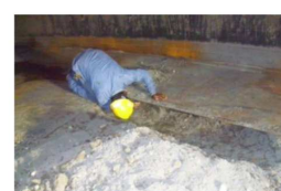
Inspección anillo anular interno al tanque
