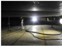
Sandblasting del piso nuevo
