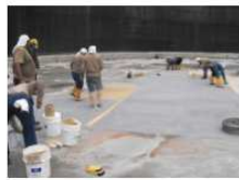
Aplicación del recubrimiento al piso nuevo.
