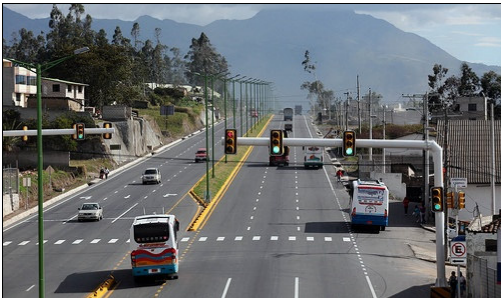
Fotografía 14.14.1: Intersección SemafORIZADA “San-Roque”, Autovía “Otavalo-Ibarra”
