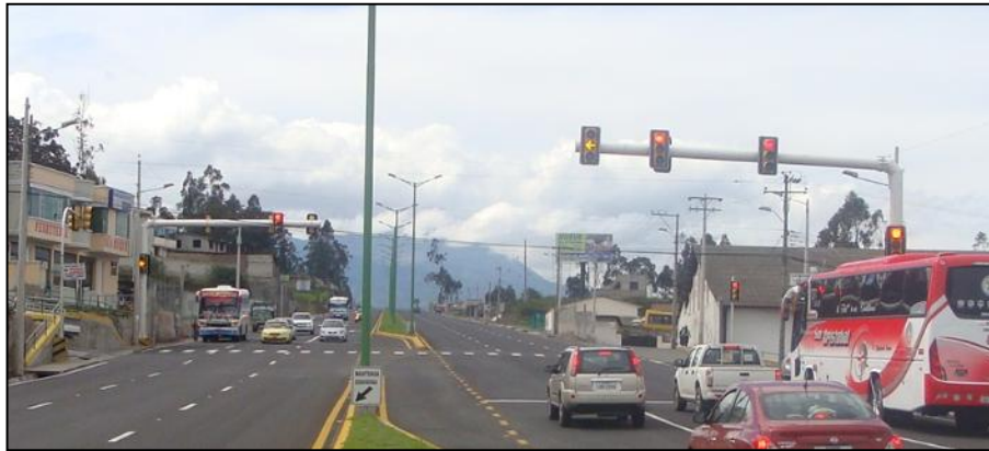
Fotografía 5.3 Disposición de los Semáforos - Intersección Autovía "Otavalo-Ibarra"
