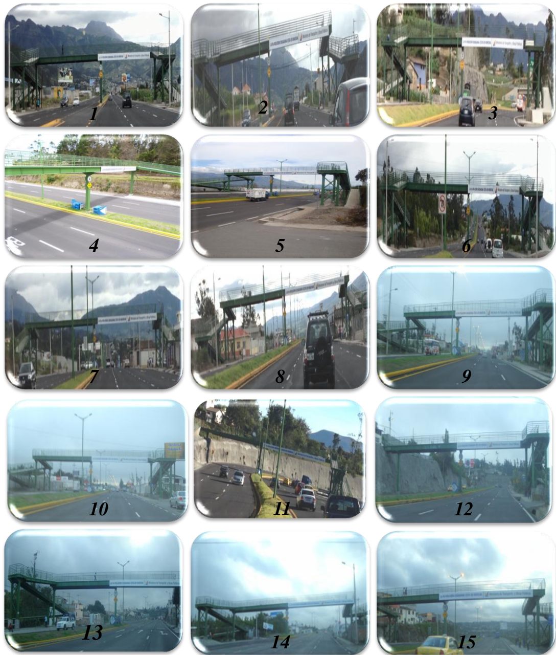
Fotografía 2.2 Puentes Peatonales (Numerados) Autovía "Otavalo-Ibarra"
