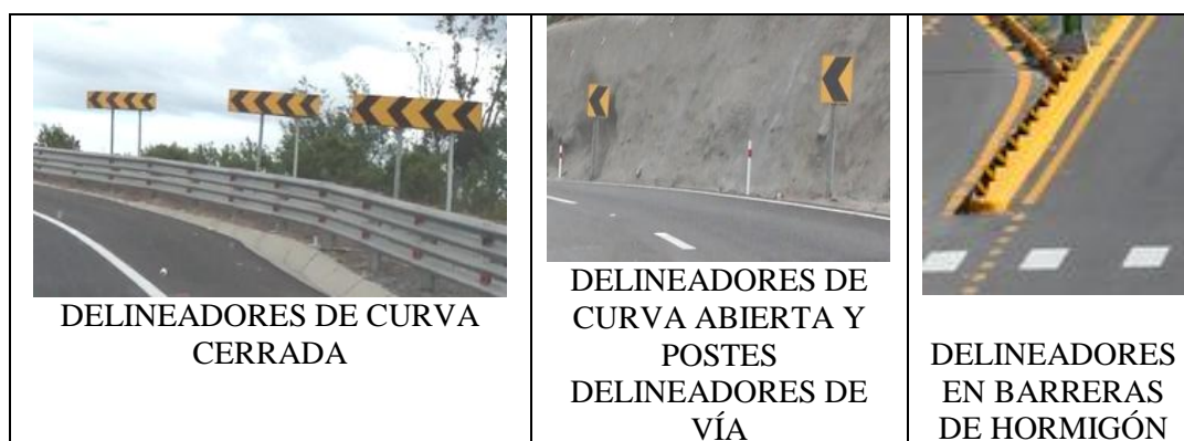
Figura 5.15 Señales de Alineamiento Horizontal Autovía "Otavalo-Ibarra"
