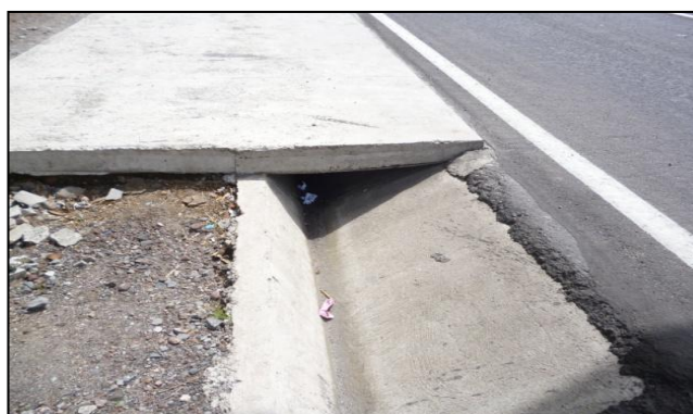
Fotografía 5.2 Borde exterior de calzada Autovía "Otavalo - Ibarra"
