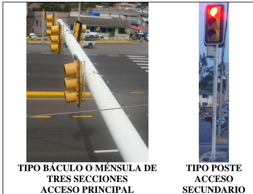
Figura 5.17 Postes de Semáforo Autovía "Otavalo-Ibarra"
