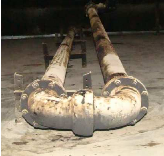
Figura 2.20.- Bajantes y Swivel (Codo Giratorio) [26]
