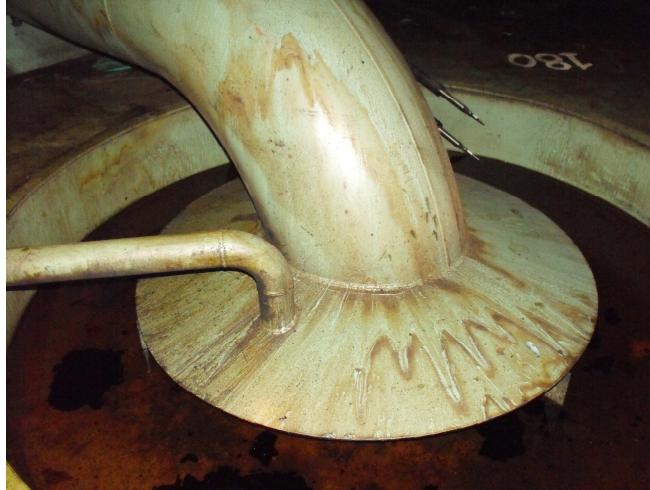
Figura 2.21.- Sistema de Drenaje de Agua de Formación [27]
