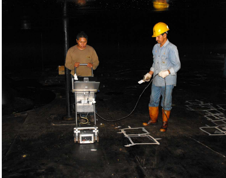
Figura 4.3 Medición de espesores por ultrasonido [47]
