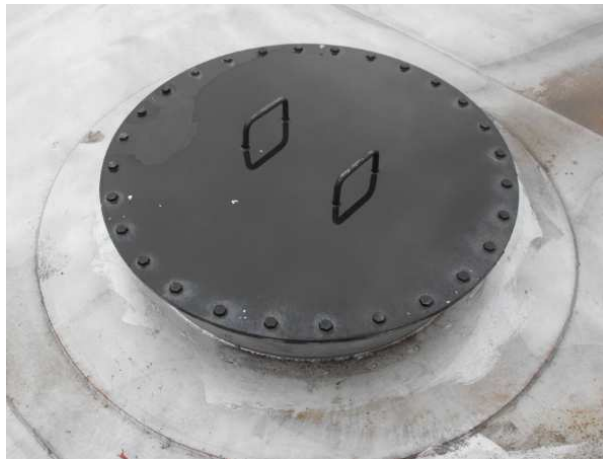
Figura 2.26.- Manhole en el Techo [32]
