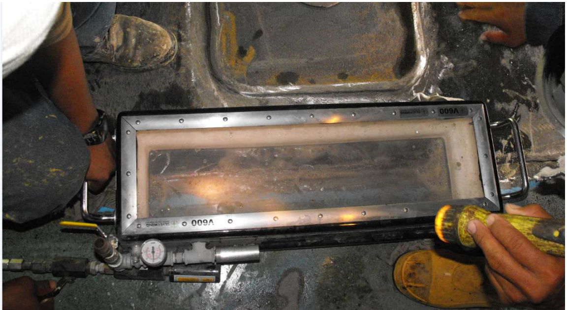
Figura 4.6 Prueba de vacío al cordón de soldadura [50]
