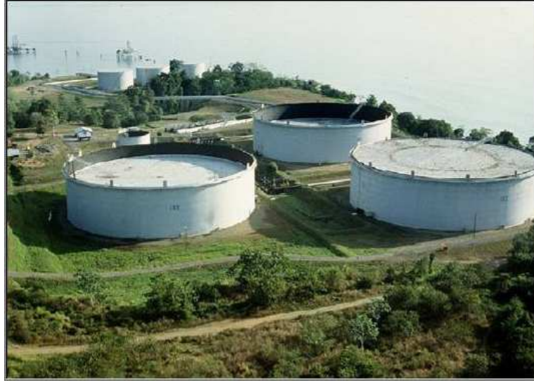
Figura 2.1.- Tanques de Almacenamiento [7]
