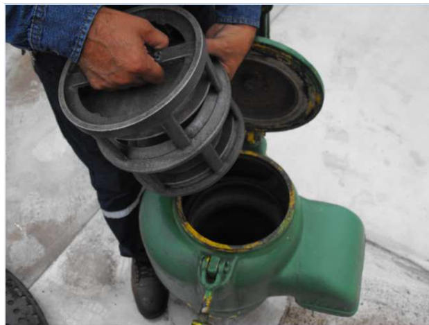
Figura 2.8.- Válvulas de Presión y Vacío [14]
