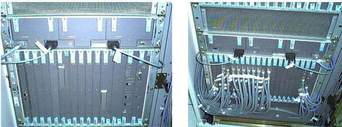
**Figura. 4.8. Repisa de los terminales de señalización Central Ericsson ENGINE**
