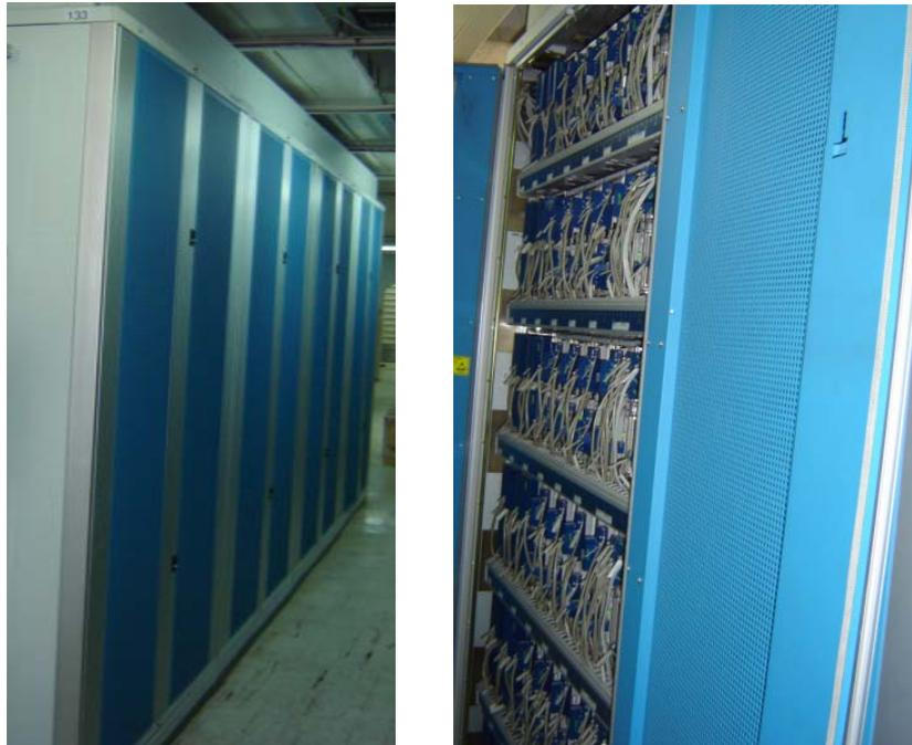
Figura. 4.5. Bastidor Central AXE 10
