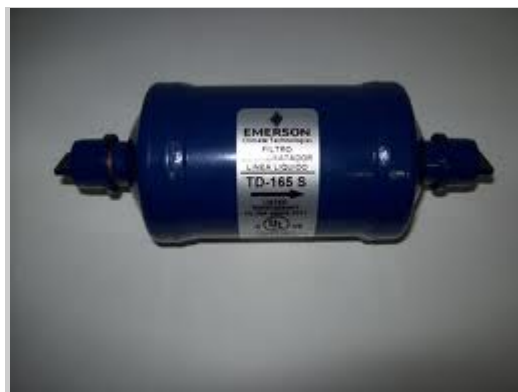
Figura 25. Filtro Secador
