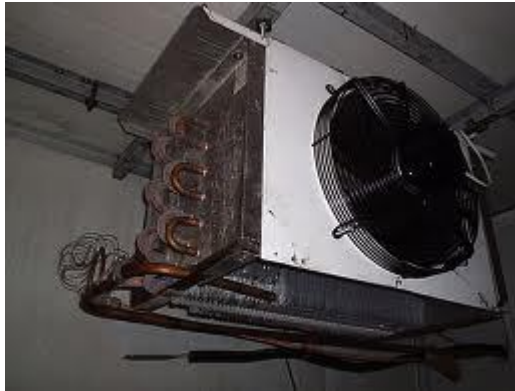
Figura 14. Evaporador Sobrealimentado
