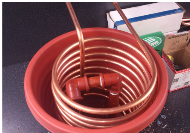
Figura 70. Instalación del Intercambiador de Calor.
