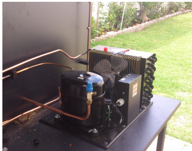
Figura 68. Instalación de la Unidad Condensadora
