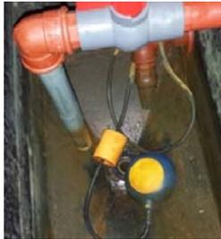
**Figura 78.** Sistema De Seguridad De La Bomba
