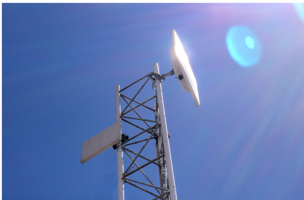
**Figura 155 Equipos Teletronics' SLAB 5826 con antena integrada instalados en la torre Sucursal Nayón**
