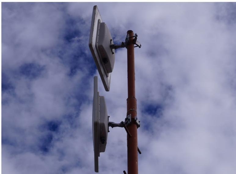
**Figura 167 Equipos Teletronics' SLAB 5826 con antena integrada instalados en el mástil Sucursal Puenbo**
