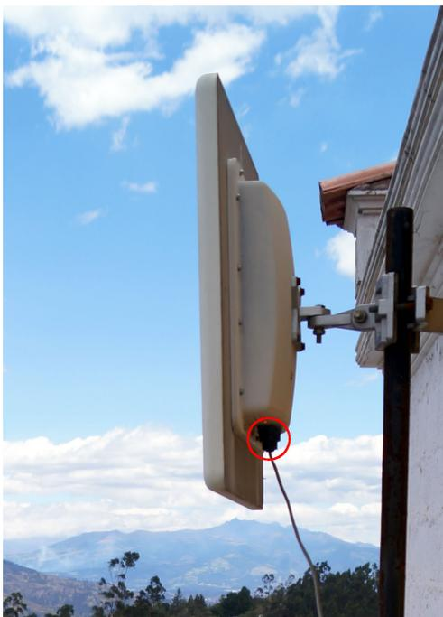
**Figura 152 Conexión del Equipo SLAB 5826 (ODU) mediante Cable Ethernet (CAT 5) Matriz Nayón**
