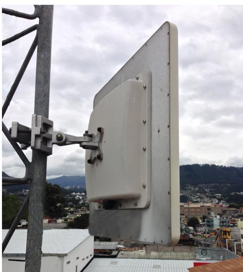
**Figura 159 Equipo Teletronics' SLAB 5826 con antena integrada instalado en el torre Sucursal Cumbayá**
