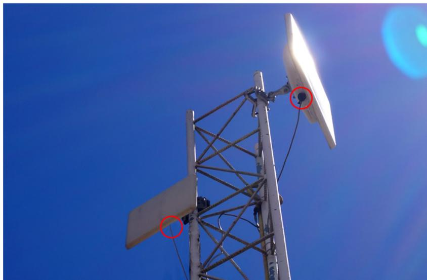
**Figura 156 Conexiones de los Equipos SLAB 5826 (ODU) mediante Cable Ethernet (CAT 5) Sucursal Nayón**
