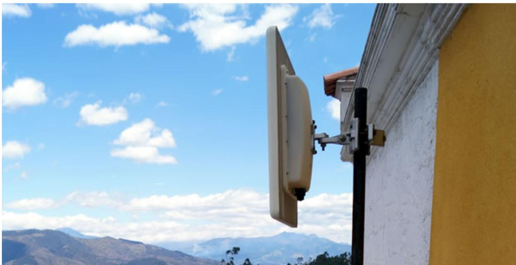
**Figura 151 Equipo Teletronics' SLAB 5826 con antena integrada instalado en el mástil Matriz Nayón**
