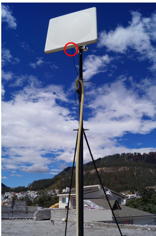
**Figura 164 Conexión del Equipo SLAB 5826 (ODU) mediante Cable Ethernet (CAT 5) Sucursal Tanda**
