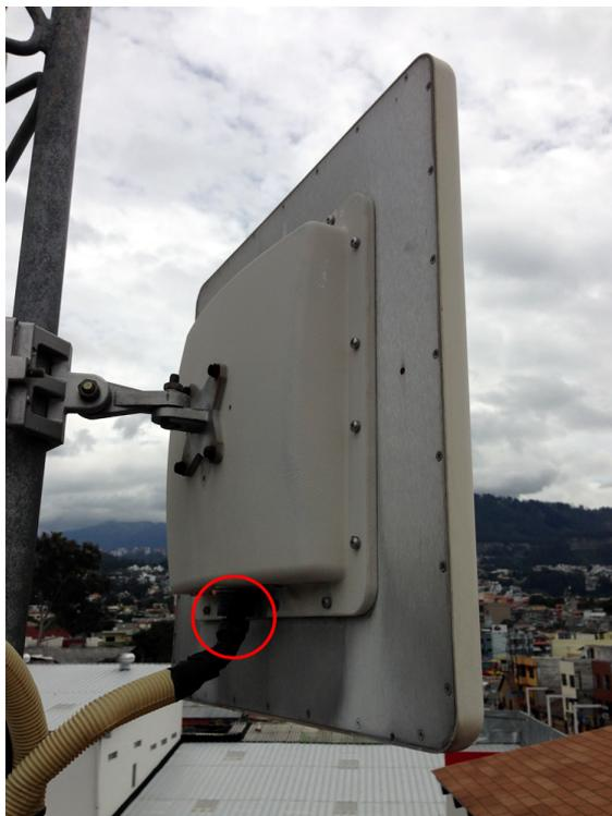
**Figura 160 Conexione del Equipo SLAB 5826 (ODU) mediante Cable Ethernet (CAT 5) Sucursal Cumbayá**
