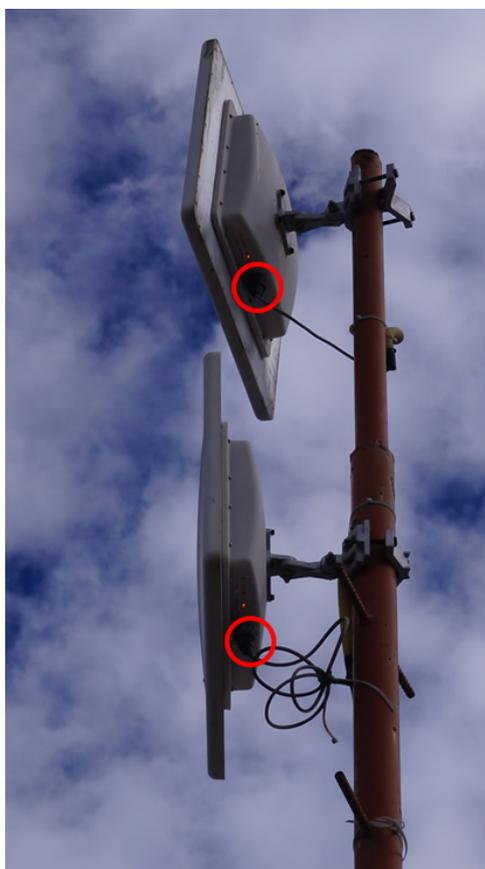
**Figura 168 Conexiones de los Equipos SLAB 5826 (ODU) mediante Cable Ethernet (CAT 5) Sucursal Puenbo**
