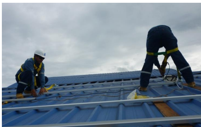
Figura 3. 3 Sujeción de perfiles en el lado derecho de la cubierta.
