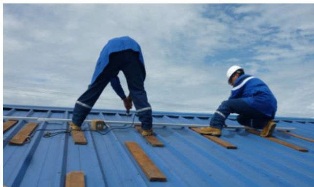
Figura 3. 2 Sujeción de perfiles en el lado izquierdo de la cubierta.
