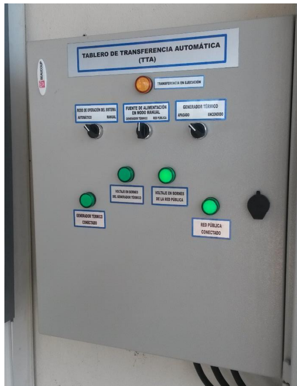
Figura 3. 20 Indicadores del tablero de transferencia.
