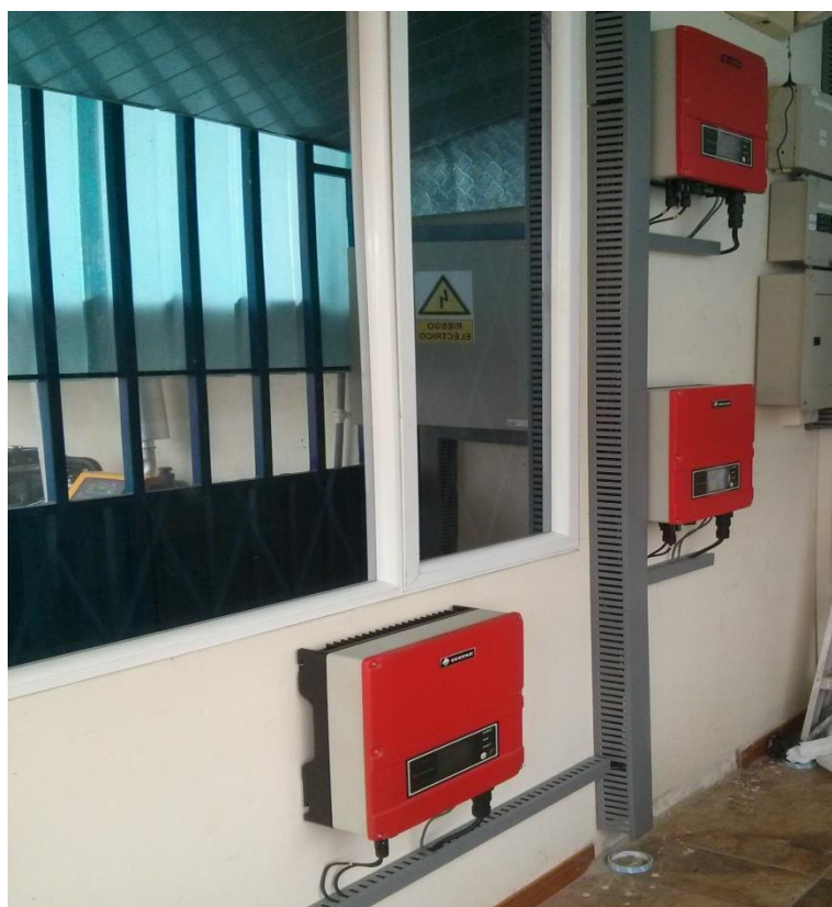
Figura 3. 10 Conexión de inversores.
