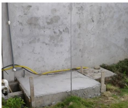
Figura 3. 15 Base destinada para el grupo electrógeno.
