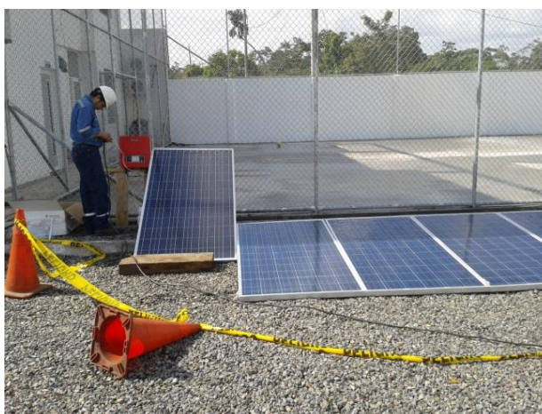
Figura 4. 2 Pruebas iniciales a los inversores.
