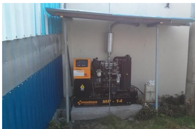
Figura 3. 16 Cubierta del grupo electrógeno.
