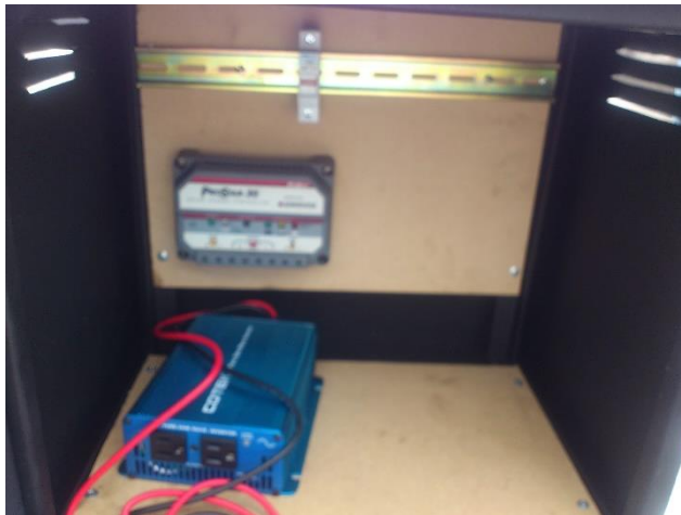
Figura 4.6 Proceso de montaje del módulo de distribución
