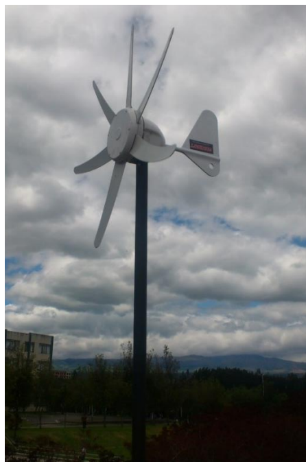
Figura 4.4 Instalación del Aerogenerador
