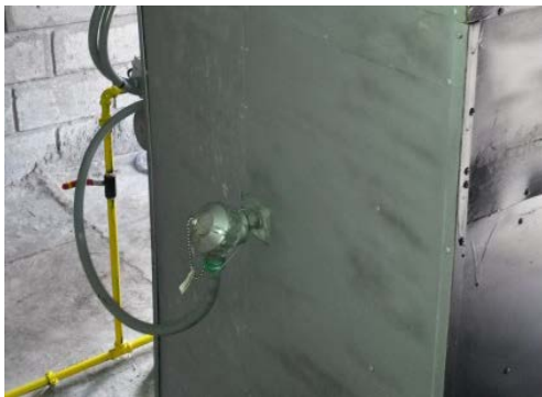
Figura 4. Termocupla K en cámara de postcombustión
