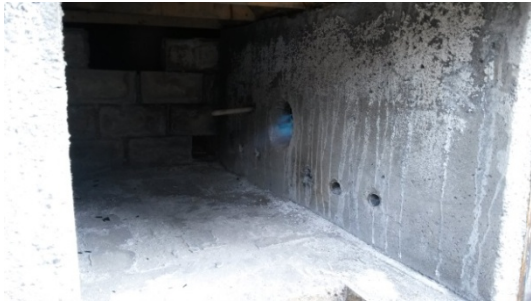
Figura 3. Termocupla K en cámara principal
