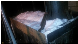
Figura 17. Aislamiento térmico a la cúpula RESULTADOS
