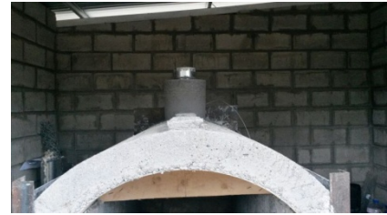
Figura 13. Cúpula de refractario y base de chimenea
