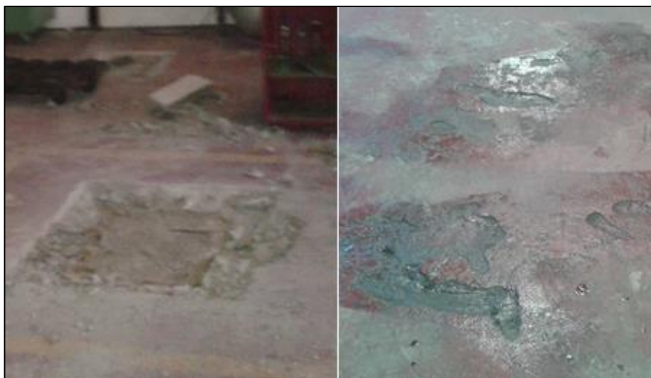
Gráfico No. 69: desgaste y averías en el piso.
