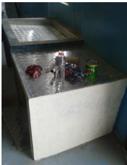
Gráfico No. 78: Adición de aluminio corrugado en la lavandería.
