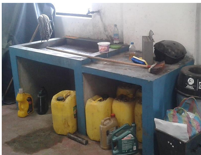
Gráfico No. 15: Lavadero en mal estado.
