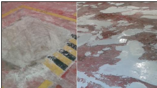
Figura No. 12: Eliminación de grietas y agujeros. Autores: Ayala A. Mogro A.
