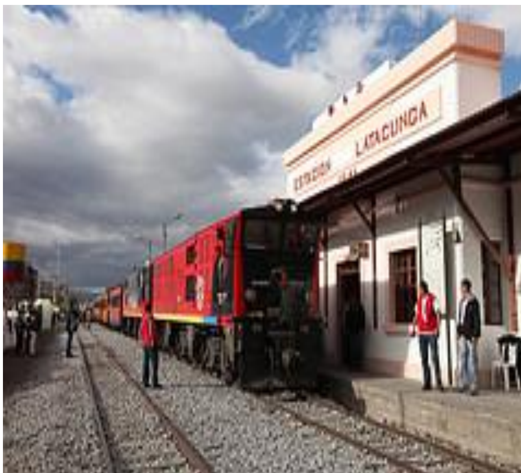
Fotografía N° 4.7 Vista frontal, de la estación del tren en la ciudad de Latacunga, calle Marco Aurelio Subía.
