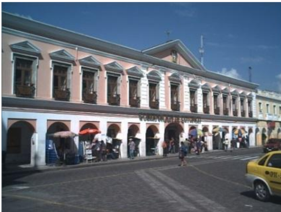
Fotografía N° 4.2 Vista frontal, calle Quito Gobernación de Cotopaxi
