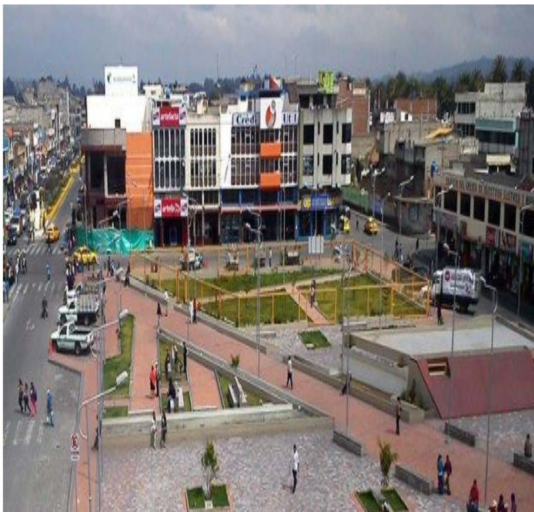
Fotografía N° 4.15 Vista frontal, plaza del Salto calle Amazonas y Guayaquil.
