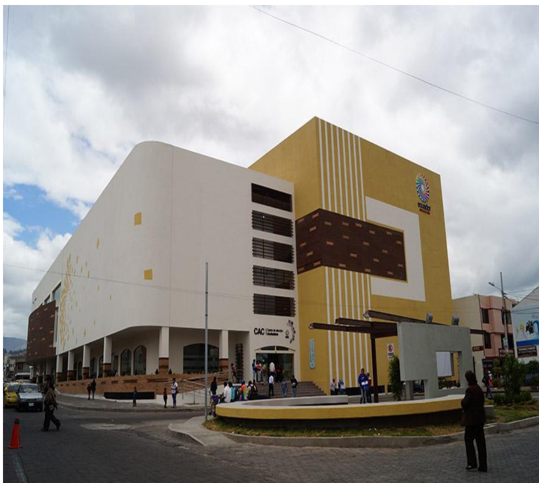
Fotografía N° 4.14 Vista lateral, edificio el Rosal, Centro de Atención Ciudadana, calle Quito
