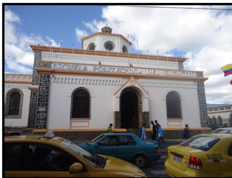
Fotografía N° 5.1 ESPE-L vista frontal calle Quijano y Ordoñez
