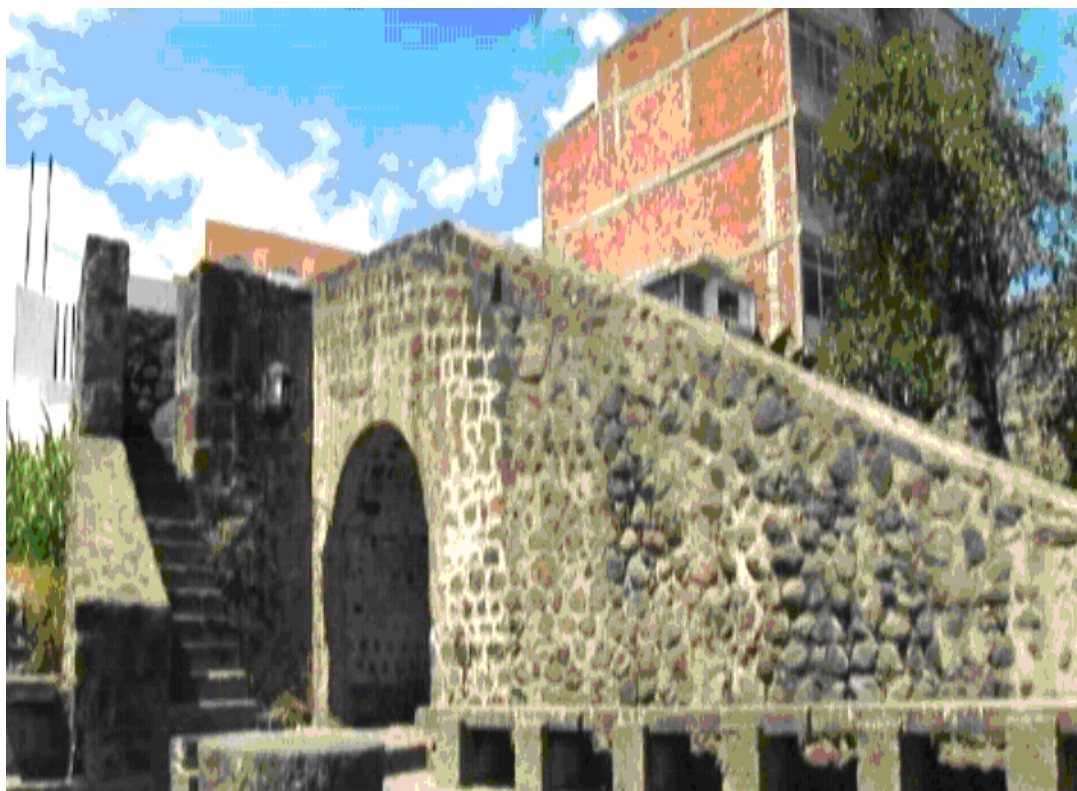
Fotografía N° 4.3 Vista interior, patio principal Casa de la Cultura
