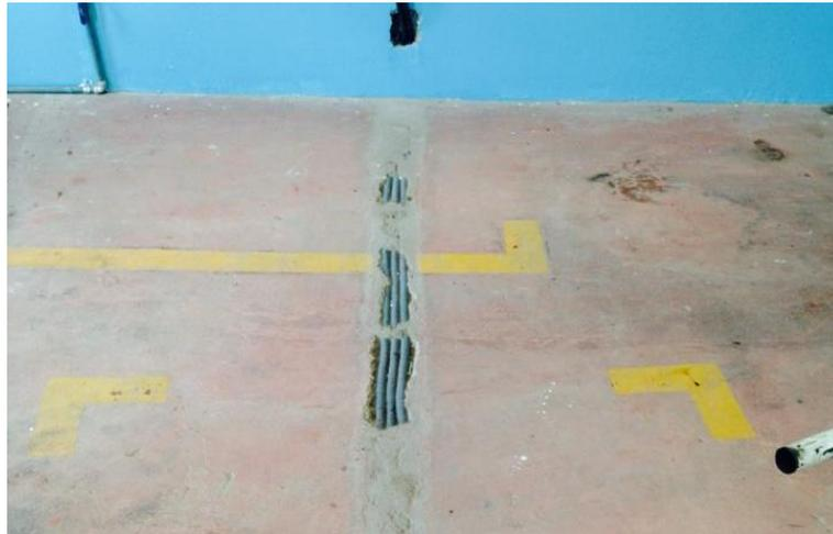
Figura 3.3. Riesgo de atrapamiento por vuelco de máquinas debido al estado del piso industrial
