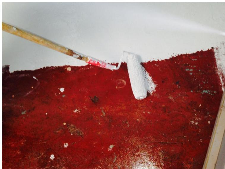
Figura 3.18. Aplicación de pintura epóxica
