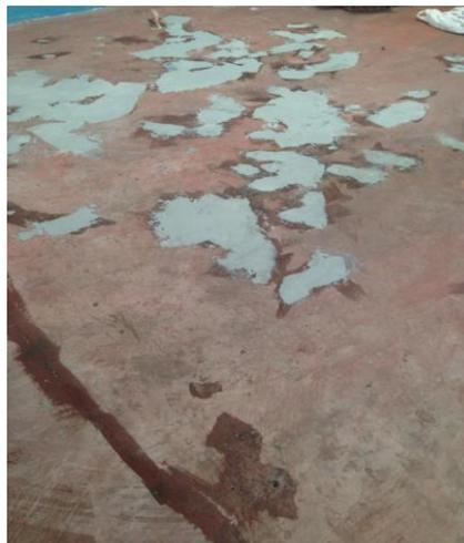
Figura 3.16. Reparación de grietas y desprendimientos
