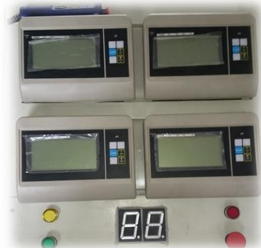
Figura No. 31: Caja de mandos Elaborado por: Pozo E. y Puma D.
