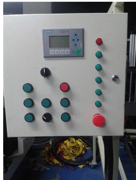
Figura 33. Montaje tablero Elaborado por: Bustillos, Diego y Ortiz, Edgar.
