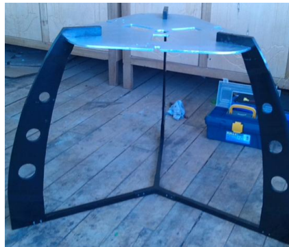
Figura 2.26 Colocación de la plataforma fija
