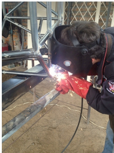
Figura 4-2. Proceso de soldadura del bastidor.
