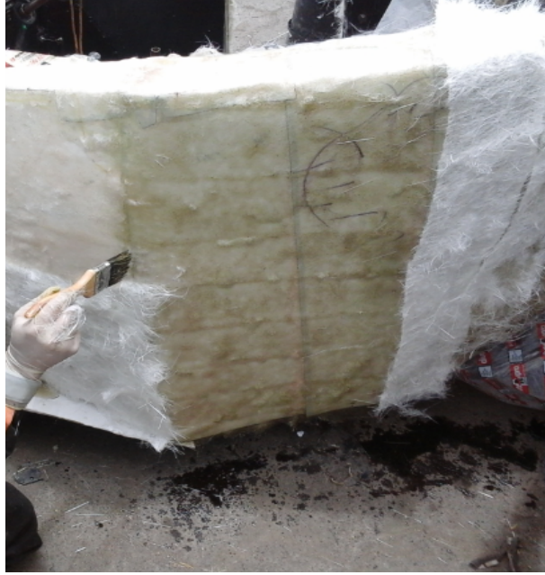
Figura 4-26. Refuerzo de fibra de vidrio
