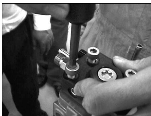
Figura 4.54. Instalación del subconjunto del elemento en el cuerpo bomba.
