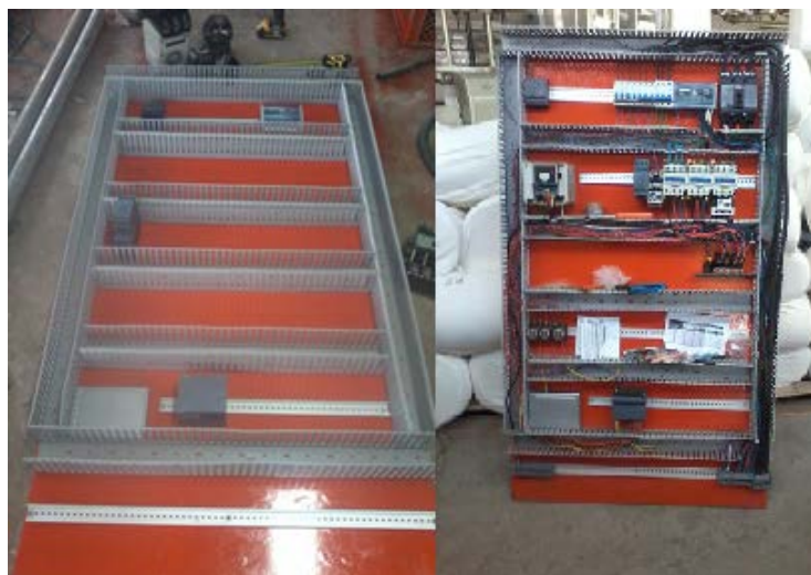
FIGURA 3.1. Tablero de Control Eléctrico. ELABORADO POR: Arroba, P. y López, J.
