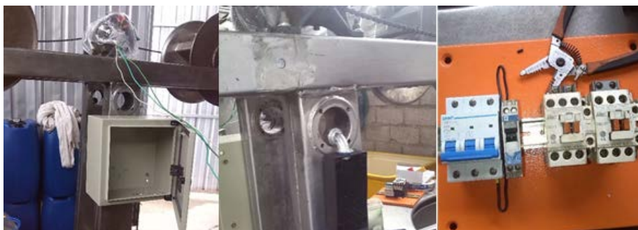
FIGURA 3.35. Ensamblaje partes eléctricas. ELABORADO POR: Arroba, P. y López, J.
