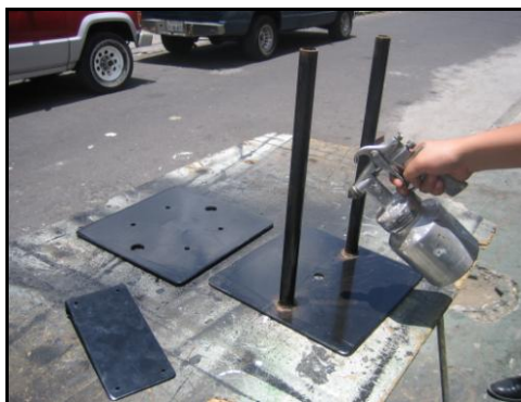
Figura 5. 17 Proceso de pintura
