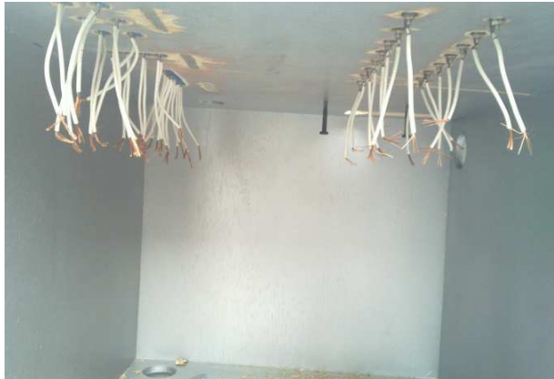
Gráfico No. 3.52: Colocación del cableado para pruebas.
