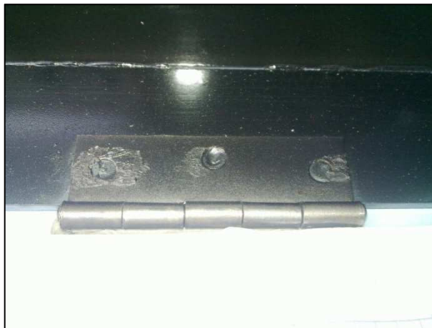
Gráfico No. 3.47: Bisagras para sujetar la cubierta de vidrio.
