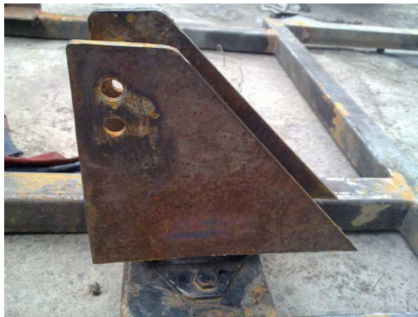
Gráfico No. 3.6: Colocación de la base en la estructura.
