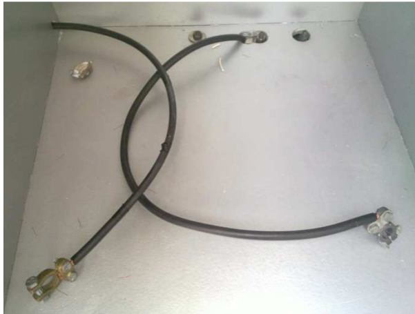
Gráfico No. 3.33: Instalación de cables de conexión a la batería.
